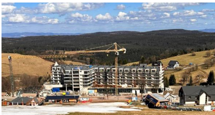
Fot. 15. Budowa hotelu Infinity w Zieleńcu. Autor: Andrzej Dobkiewicz. Źródło: walbrzych.wyborcza.pl
