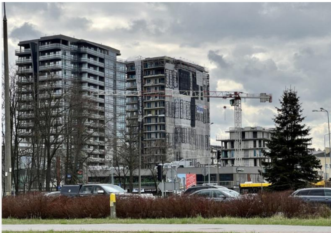
Fot. 21. Kompleks Plaza Tower w Kielcach. Źródło: inwestycje.kielce.pl
