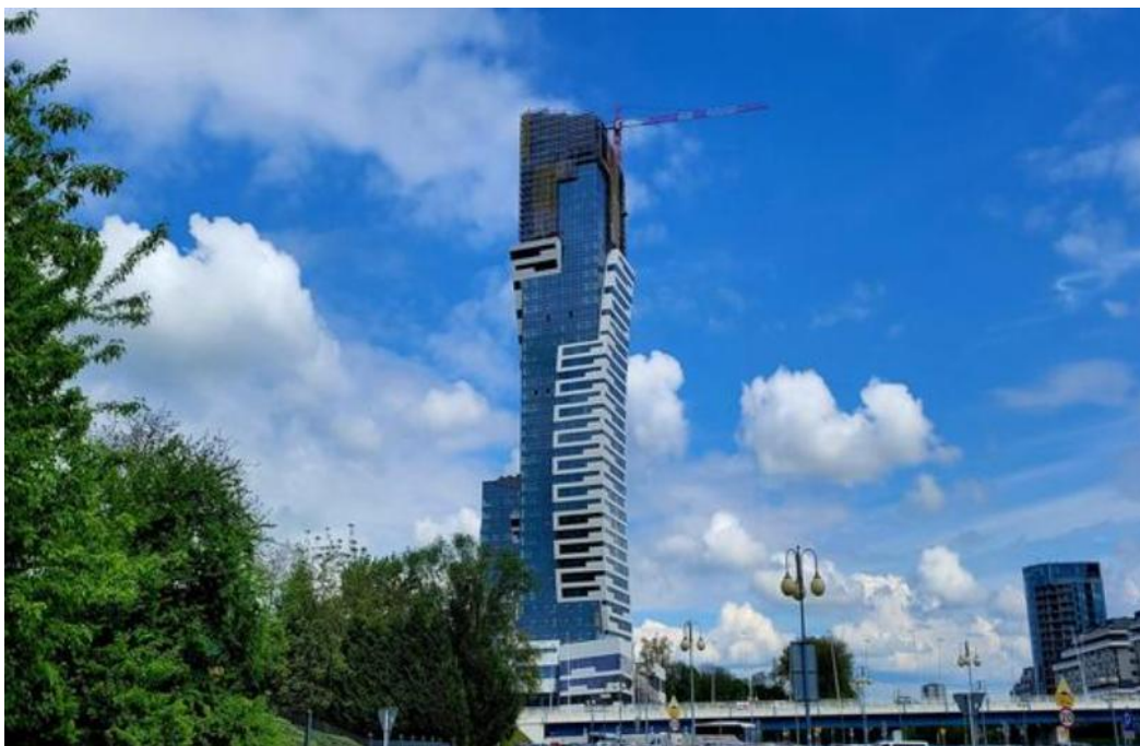
Fot. 5. Wieżowiec Olszynki Park w Rzeszowie w trakcie budowy. Źródło: olszynkipark.pl/obiekty-mieszkalne.muratorplus.pl
